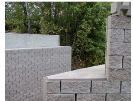
Most u obce Královec – detail úložného prahu
