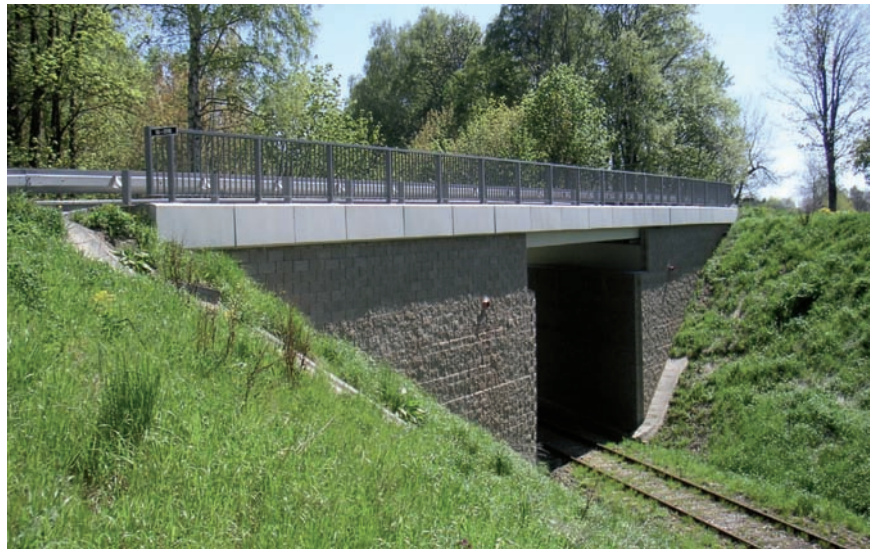
Most u obce Královec – dokončená konstrukce
