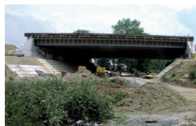
Most na dálnici D1 v úseku Vyškov – Mořice – osazení nosné konstrukce
