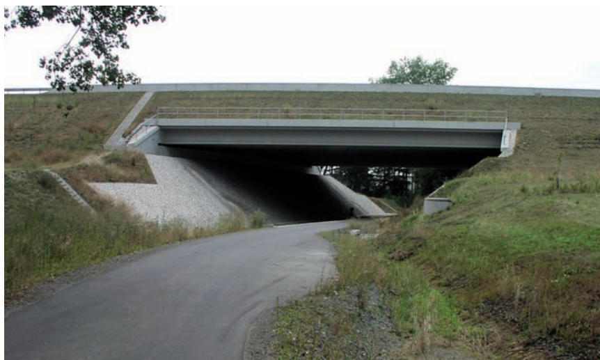
Most na dálnici D1 v úseku Vyškov – Mořice – dokončená konstrukce
