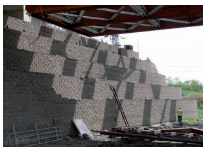
Most na dálnici D47 – uložení nosné konstrukce
