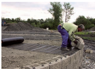
Most na dálnici D47 – výstavba opěr
