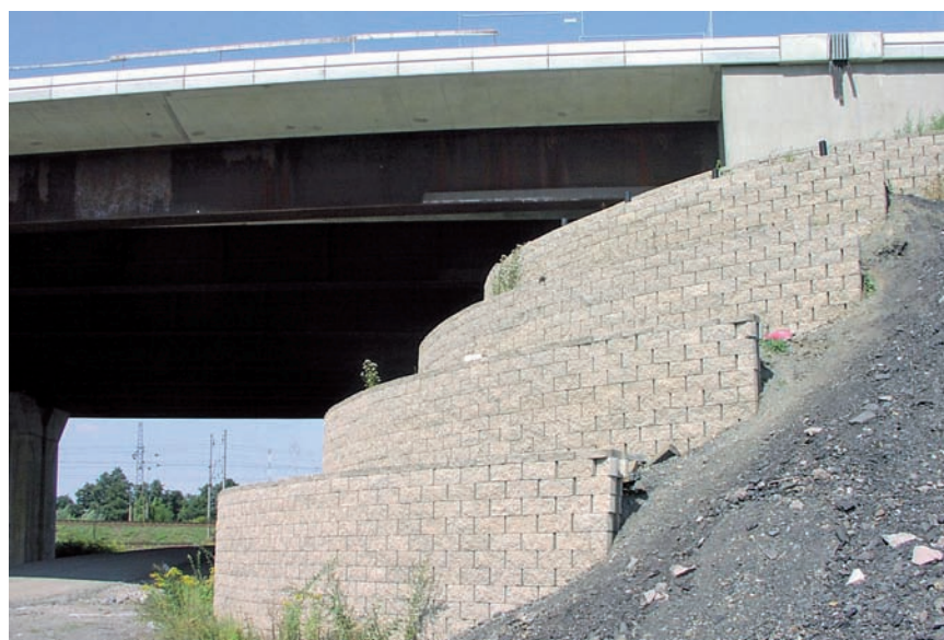
Most na dálnici D47 – opěra před ozeleněním
