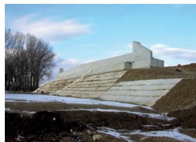
Most na dálnici D1 v úseku Vyškov – Mořice – výstavba opěr
