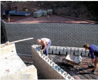
Most u obce Královec – výstavba opěr
