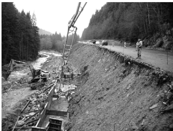
Obr.3 Zpevnění paty svahu
