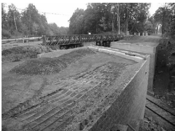
Obr.19 Dokončení úložných prahů
