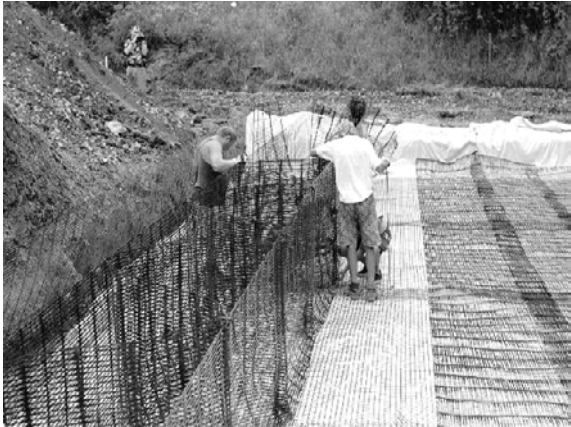
Obr.11 Výstavba geobuňkové struktury
