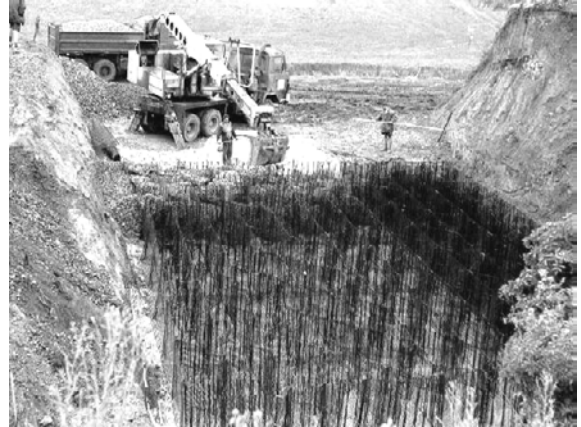
Obr.12 Vyplňování geobuňkové struktury
