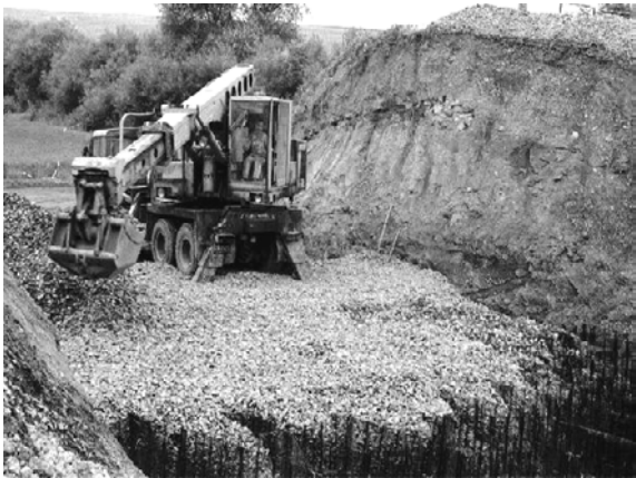
Obr.13 Vyplňování geobuňkové struktury
