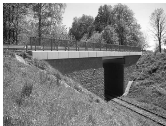
Obr.20 Most po rekonstrukci
