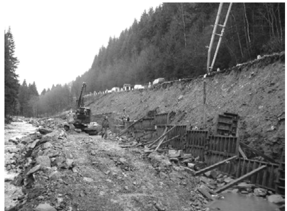
Obr.2 Úprava paty svahu
