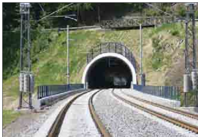
Obr. 22 Vyztužený strmý svah nad portálem tunelu Hněvkovský II
