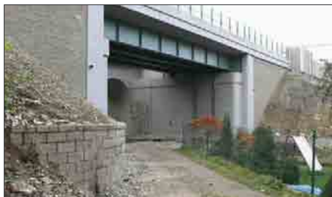
Obr. 11 Mostní křídla na železniční trati Třebovice–Rudoltice
