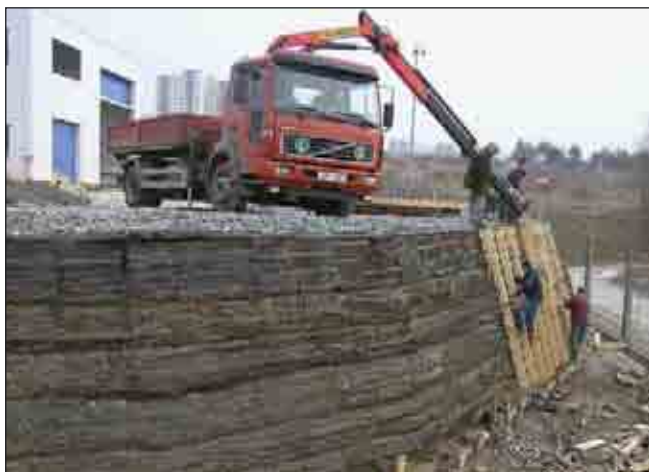
Obr. 19 Výstavba strmého svahu s obalovaným čelem v areálu stanice STK v Brně
