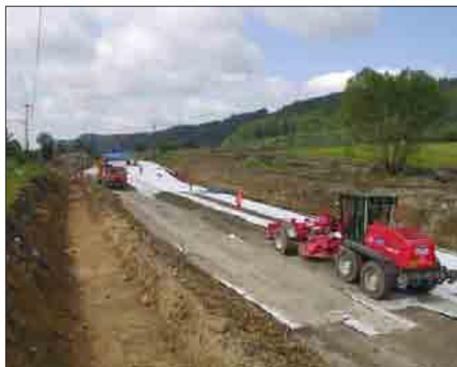
Obr. 33 Rekonstrukce a rozšíření koridorové trati Třebovice–Rudoltice v Čechách
