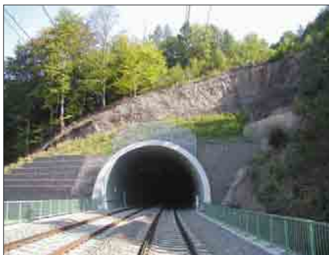
Obr. 29 Zajištění skalního masívu nad portálem tunelu Malá Huha na trase železničního koridoru Zábřeh na Moravě–Krasíkov
