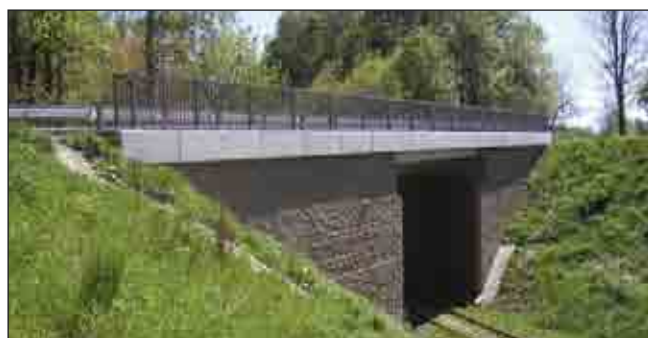
Obr. 10 První mostní opěry z vyztužené zemině v ČR byly vystavěny v roce 2004 nedaleko Královce (stavba byla nominována na Dopravní stavbu roku 2004)
