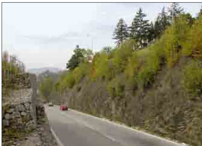
Obr. 31 Protierozní ochrana skalní stěny v Českém Krumlově
