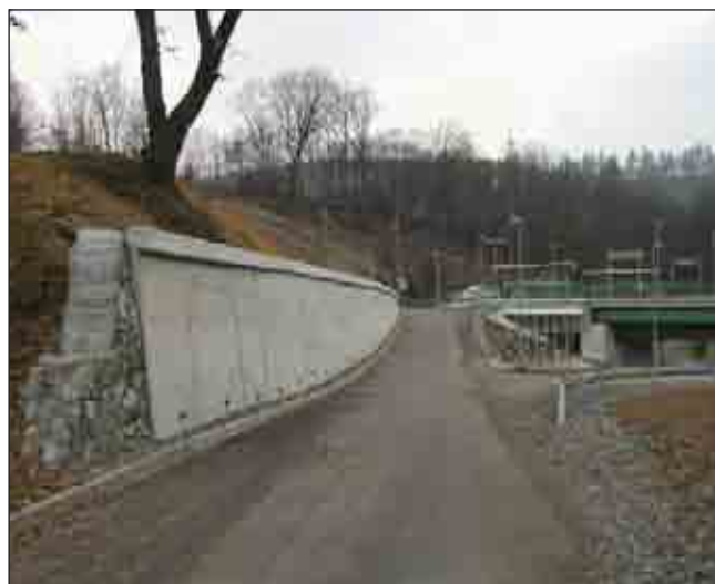
Obr. 35 Odvodnění zárubní zdi železničního mostu v obci Tatenice na trati Krasíkov–Zábřeh
