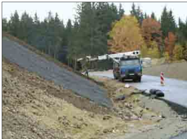
Obr. 25 Protierozní ochrana svahů na silnici II/163 Vyšší Brod–Lipno
