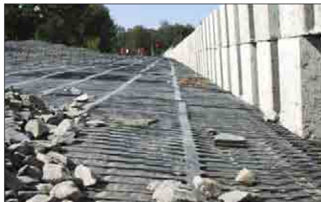
Obr. 2 Instalované geomříže spojené s líčovými tvarovkami před provedením zásypu
