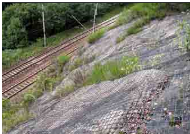
Obr. 30 Protierozní ochrana skalní stěny nad železniční tratí Havlíčkův Brod–Brno
