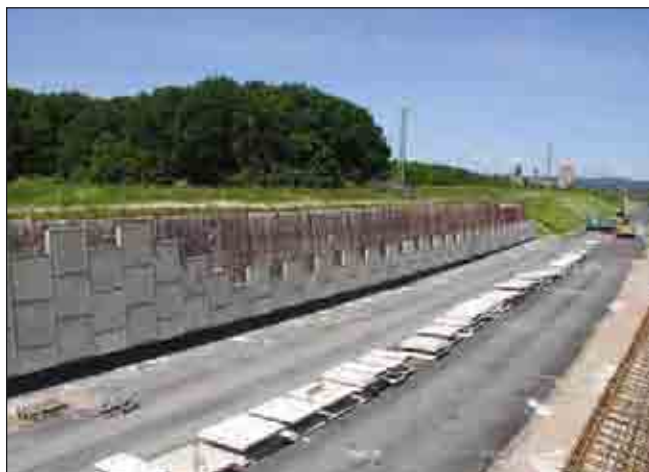
Obr. 36 Odvodnění opěrné zdi na silnici I/33, obchvat České Skalice
