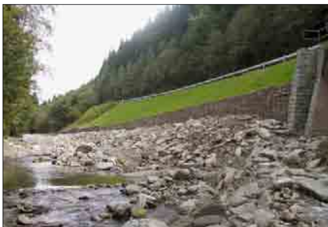
Obr. 20 Sanace sesuvu svahu po povodních u obce Pomezí boudy
