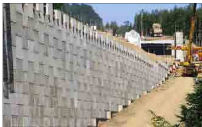
Obr. 4 Nejvyšší opěrná zeď z vyztužené zeminy v České republice, přeložka silnice I/7 Chomutov–Křimov, velkoplošné panely kotvené jednoosými geomřížemi
