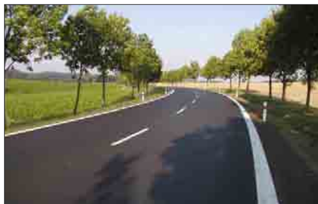
Obr. 40 Rekonstrukce krytu vozovky pomocí kompozitu v Ronově n. Sáz.
