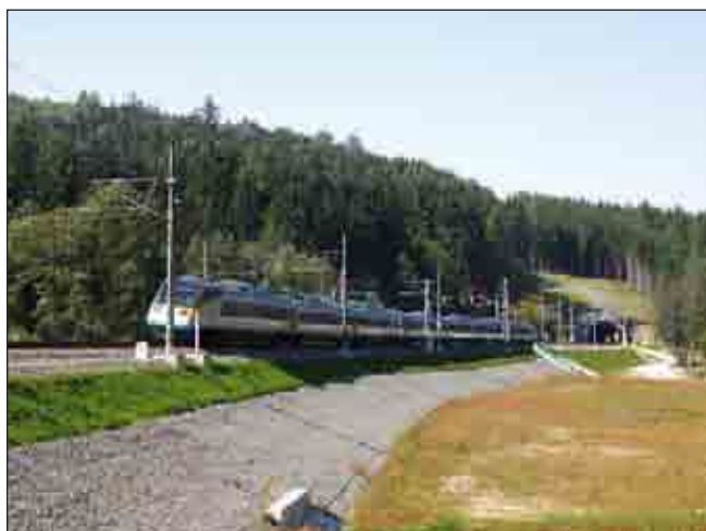
Obr. 37 Založení násypového tělesa na železničním koridoru Krasíkov–Zábřeh
