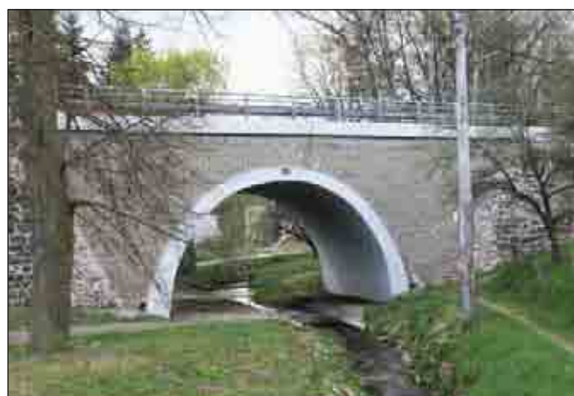
Obr. 17 Rekonstrukce mostu v Sebranicích na silnici I/43 Brno–Svitavy
