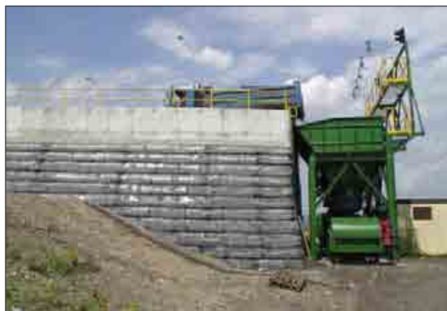
Obr. 24 Vyztužený strmý svah odkaliště Ušák v areálu elektrárny Prunéřov
