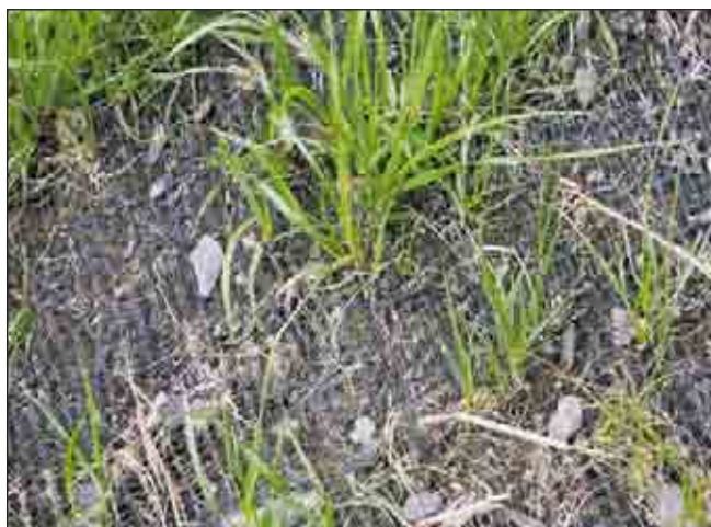
Obr. 27 Prorůstání vegetace protierozní georohoží
