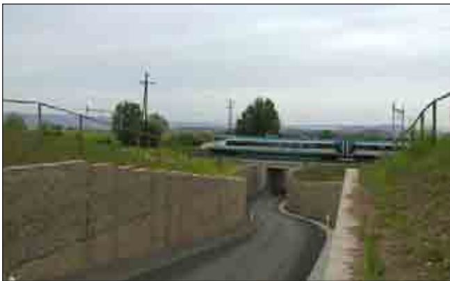
Obr. 5 Opěrné zdi podjezdu železničního koridoru Česká Třebová–Zábřeh u obce Damníkovi
