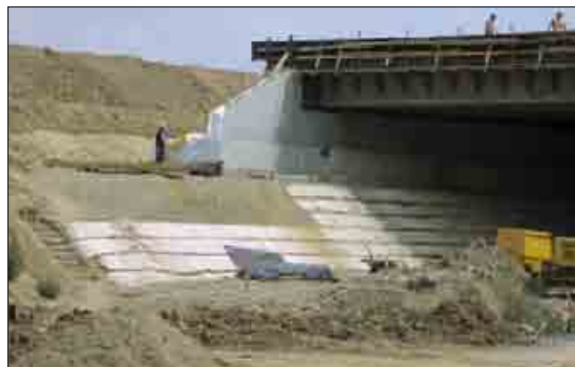
Obr. 16 Výstavba mostních opěr s obalovaným čelem na dálnici D1 v úseku Vyškov–Mořice
