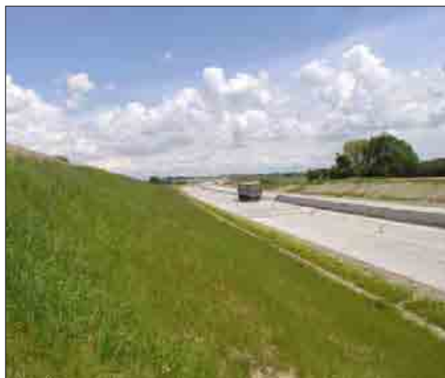
Obr. 34 Využití vlastností drenážních geokompozitů na dálnici D11 v katastru obce Dobšice
