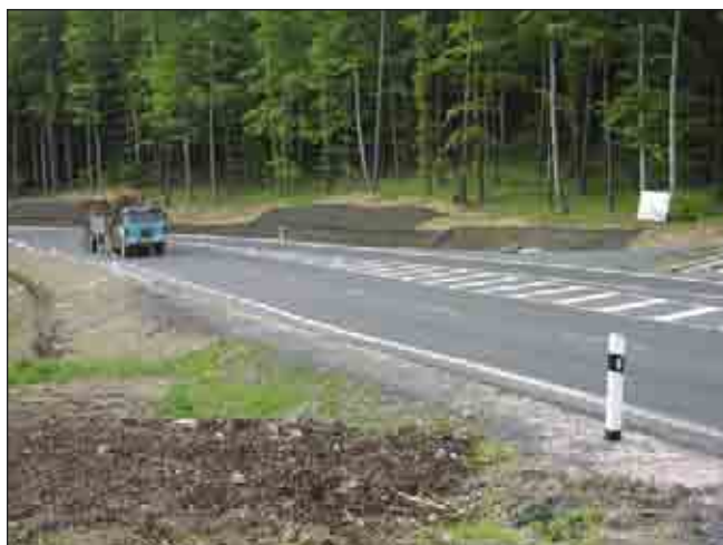
Obr. 26 Protierozní ochrana svahů na silnici I/50 Střílky–Stupava
