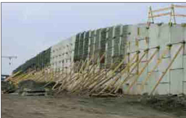
Obr. 6 Výstavba opěrné zdi z velkoplošných panelů kotvených monolitickými geomřížemi, dálnice D47 v Ostravě
