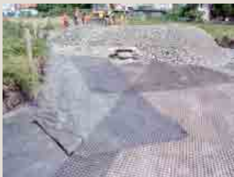
Stabilizace podkladních vrstev komunikací v obci Pátek
