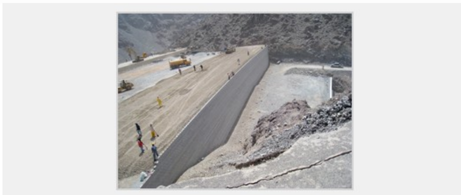
Obrázek č. 5. Výstavba nejvyšší zdi ze systému Tensartech TW1
