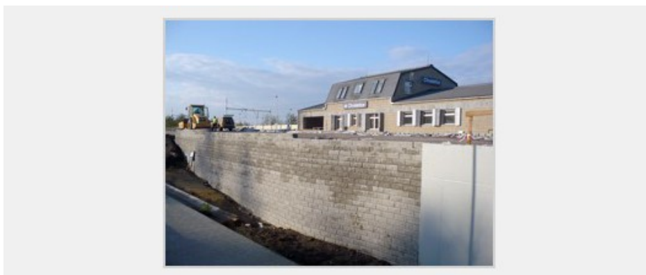
Obrázek č. 7. Systém Tensartech TW1 v Chvaleticích v průběhu výstavby
