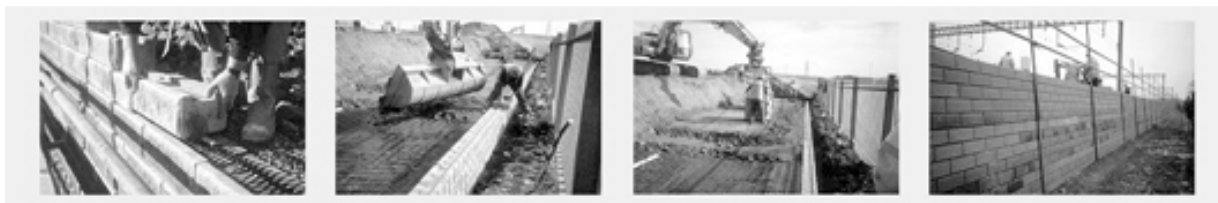
Obrázky č. 1–4. Výstavba první zdi ze systému Tensartech TW1
