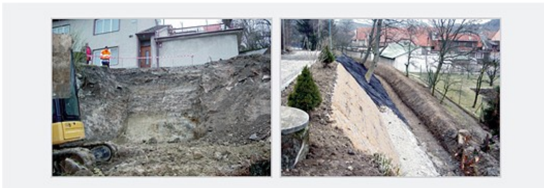
Obrázek č. 4: Louka – pohled na sesuv a dokončenou konstrukci
