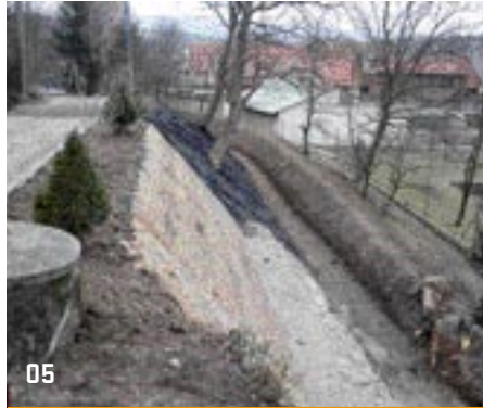
05 > Z průběhu výstavby (systém GreenSlope)
