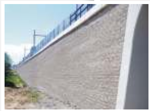
Votice Zeď na železničním koridoru
