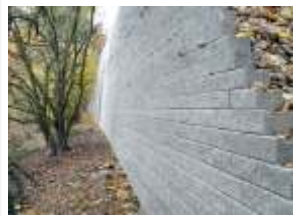
Jirkov Vyrovnání terénu pro rezidenční výstavbu
