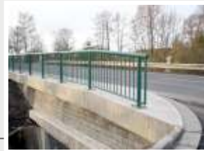
Opatov Parapetní zdi na mostě na silnici I/43
