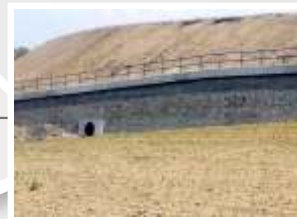
Rychaltice Opěrná zeď na doprovodné komunikaci na silnici I/48
