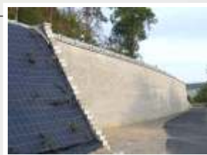
Buovice Tensartech TW1 na silnici I/50
