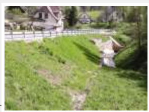
Debrné Sanace sesuvu svahu komunikace
