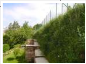
Ledeč nad Sázavou Sanace sesuvu historických hradeb
