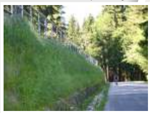
Prášíly Tensar tech GreenSlope na cyklostezce
