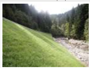
Pomezí boudy Sanace sesuvu svahu po povodních
