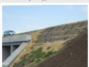
Sulec Strmé svahy násypů na silnici R7
