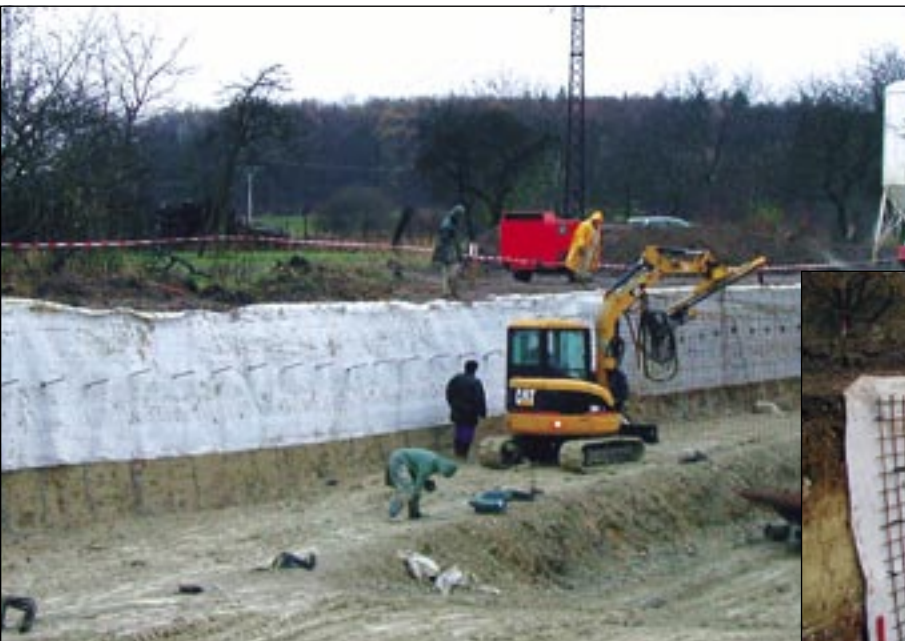
Silnice I/33 Česká Skalice
