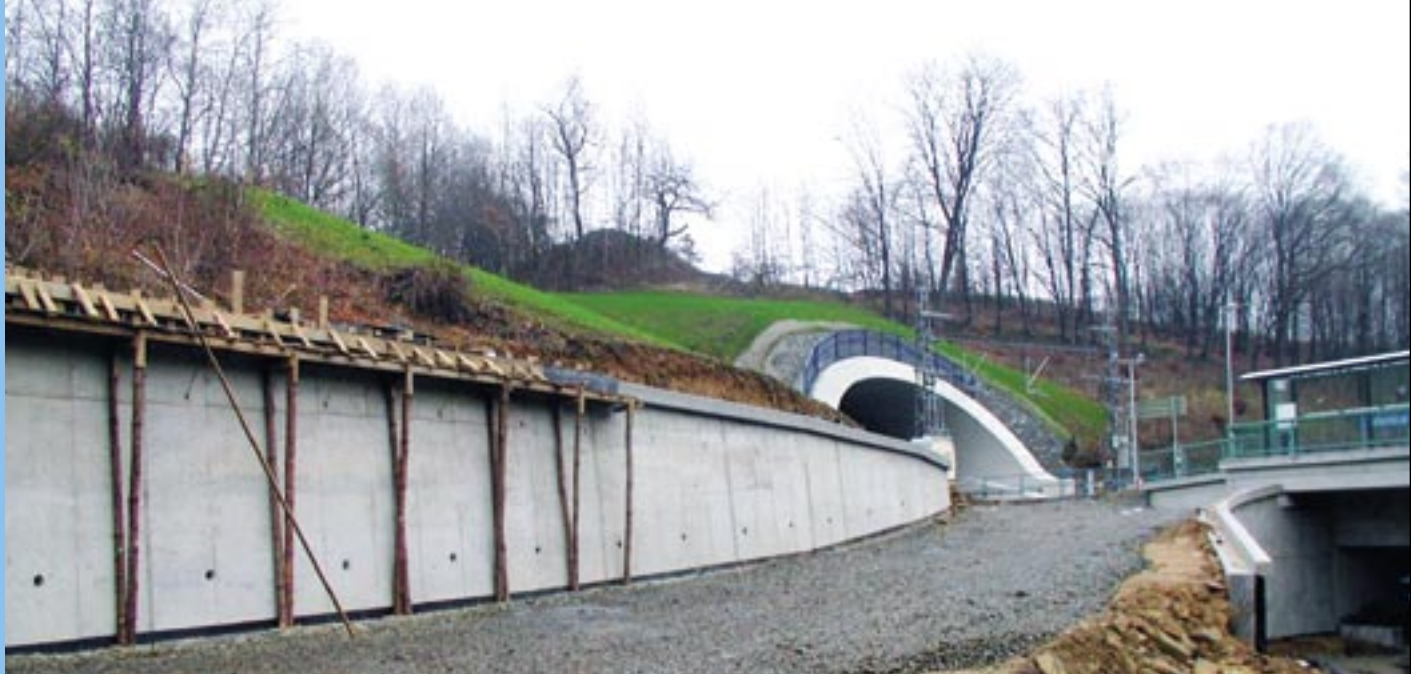
Svislá drenáž za opěrnou zdí (Tatenice)
