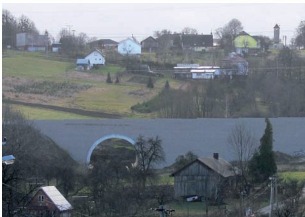
Obr. 8 Opěrné zdi z blokového systému z betonových tvarovek na silnici Tošanovice–Žukov, délka zdi je přes 100m
