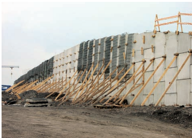
Obr. 7 Výstavba opěrné zdi z velkoplošných dělených panelů kotvených monolitickými geomřížemi, dálnice D47 v Ostravě
