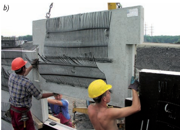
a) Obr. 4 Zabudované zárodky geomříží Tensor na rubové straně děleného panelu a), b)
