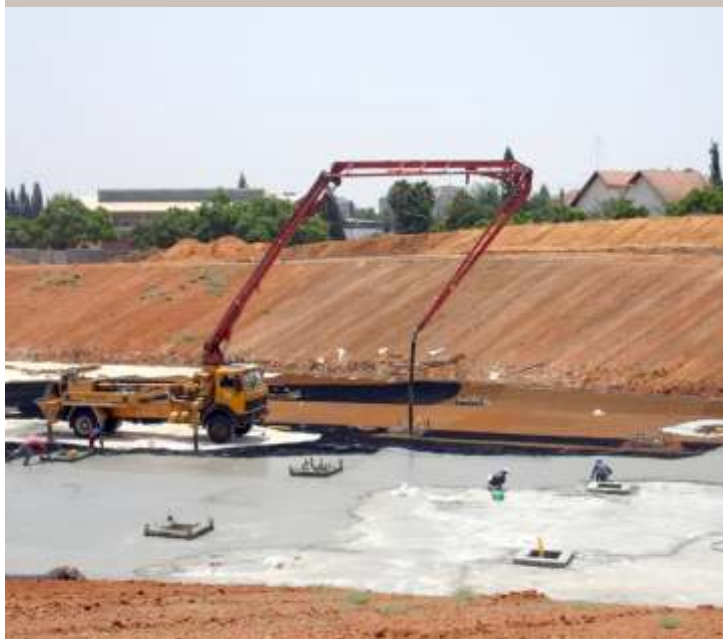
Stabilizace dna retenční nádrže
