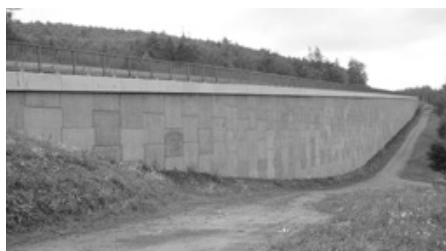
01 > Nejvyšší opěrnou zdí z vyztužené zeminy v České republice je zeď na přeložce silnice I/7 Chomutov-Křimov, velkoplošné panely jsou kotvené jednoosými
