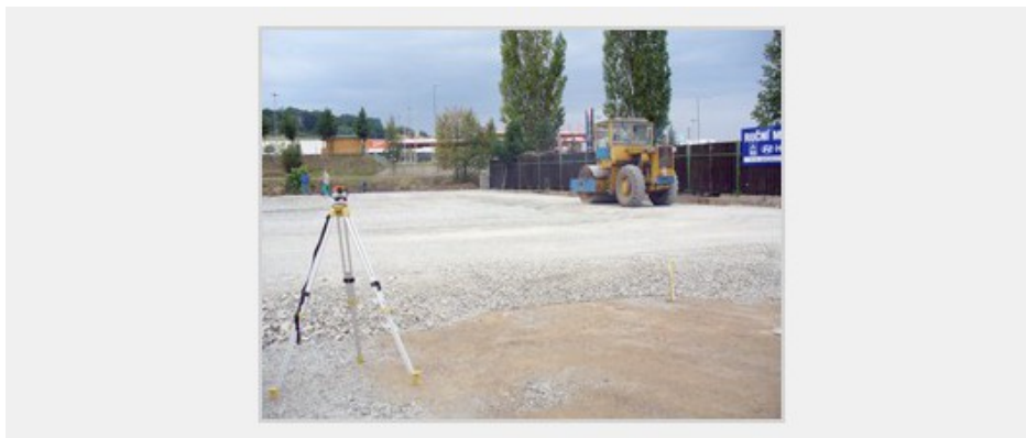
Obrázek č. 5. Zhutňování zasypu
