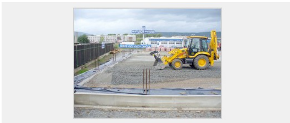
Obrázek č. 6. Koordinovaná výstavba geodesky a základových pasů
