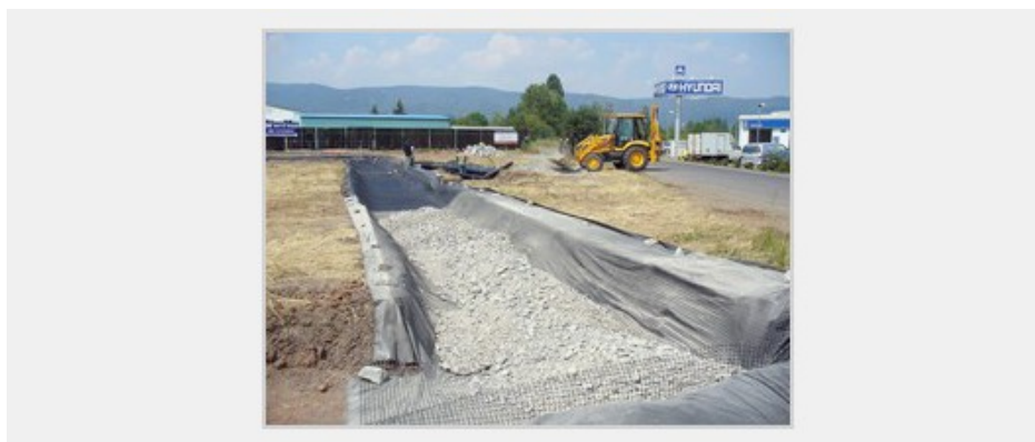
Obrázek č. 4. Pohled na neomříží stabilizovaný roznášecí polštář navržený pod nosnými zdmi objektu
