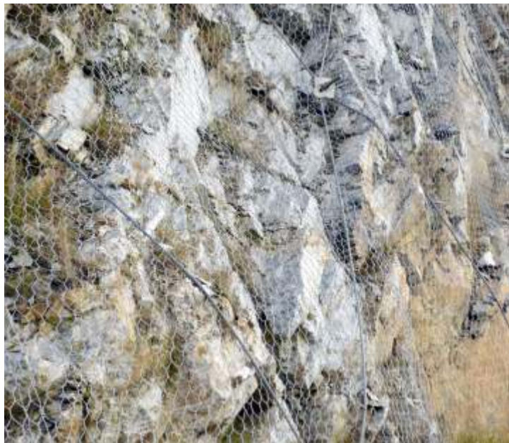
Protierozní ochrana svahu snadno tvarovatelnou ocelovou geosítí
