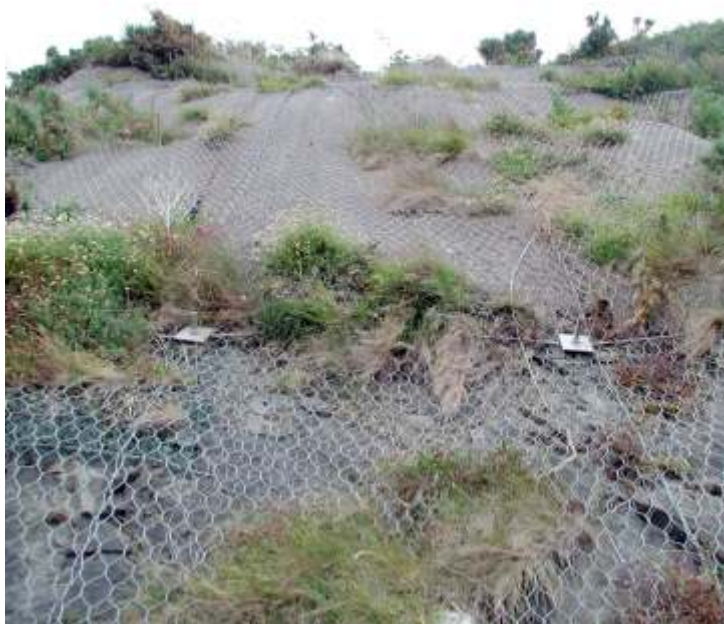
Pohled na skalní stěnu s instalovanou geosítí a již vzrostlou vegetací
