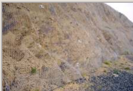
Ukotvená geosíť v silničním zářezu
