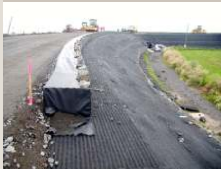
Protierozní ochrana svahů násypu silnice II/247 v Litoměřicích
