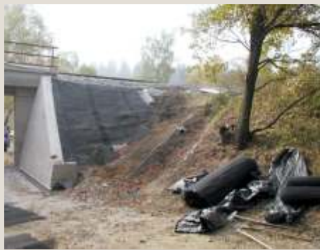
Použití protierozní georochože Trinter na svahy mostního křídla při rekonstrukci železničního mostu v Hesově
