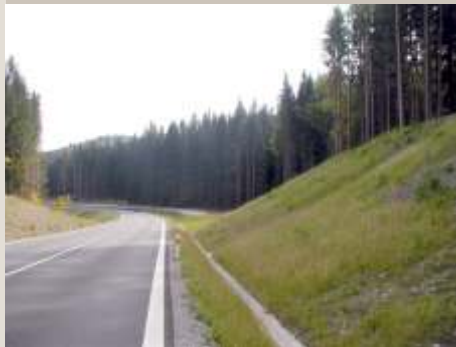
Protierozní ochrana svahů silnice II/163 Vyšší Brod - Lipno nad Vltavou
