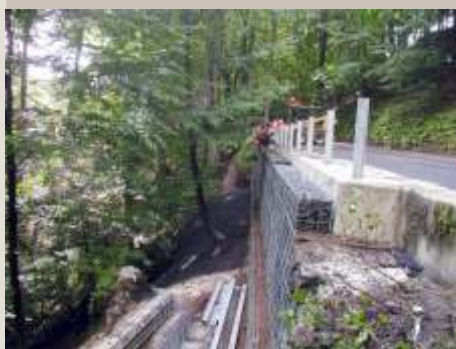
Protierozní ochrana sanovaného svahu po sesuvu na silnici III/2823 Hrubá Skála
