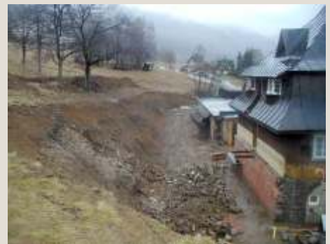
Protierozní ochrana sanovaného svahu po sesuvu ve Špindlerově Mlýně
