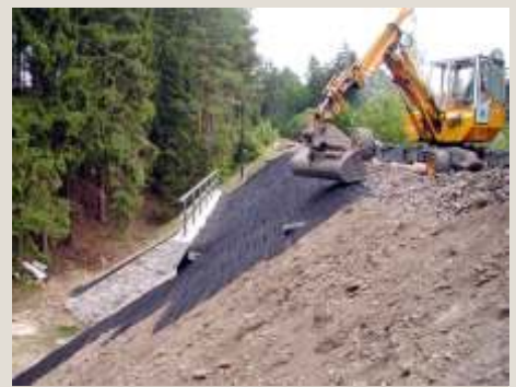
Použití protierozní georochože Trinter na svahy mostního křídla při rekonstrukci železničního mostu v Urbanči
