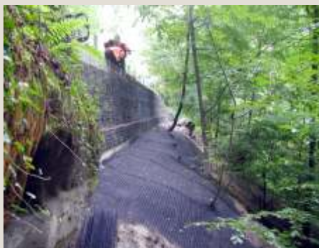
Protierozní ochrana sanovaného svahu po sesuvu na silnici III/2823 Hrubá Skála
