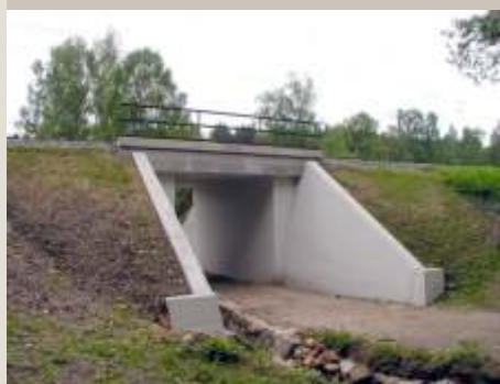
Použití protierozní georochože Trinter na svahy mostního křídla při rekonstrukci železničního mostu v Hesově
