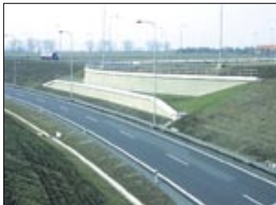
Stupňovitá opěrná stěna v prostoru dálniční křižovatky (Olomouc)
