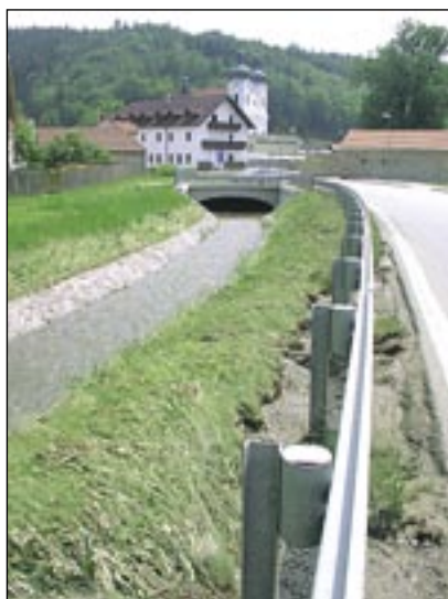
Protierozní ochrana koryta potoka brání každoročním povodňovým škodám (Sloup)
