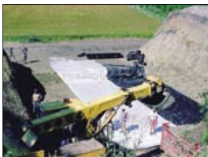
Výstavba geobuňkové struktury na zvodněném podloží (Holubice)
