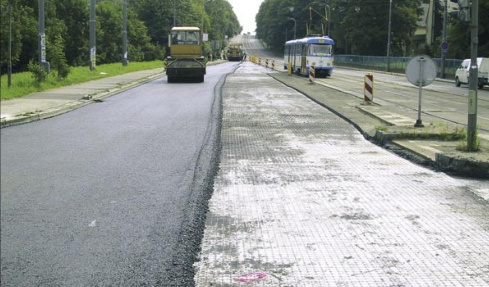
Snížení deformací krytu vozovky při rekonstrukci křižovatky (Ostrava)
