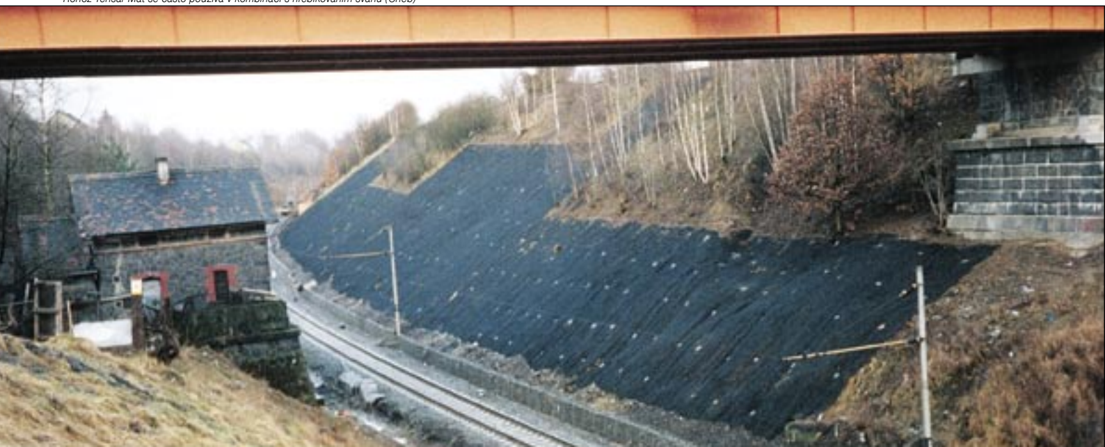
Rohož Tensar Mat se často používá v kombinaci s hřebíkováním svahu (Cheb)
