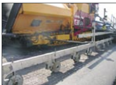
Pokládka asfaltové vrstvy na výrobek Tensar ARG (Mirošovice - Senohraby)
