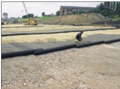
Vícevrstvá konstrukce zakrytí skládky
