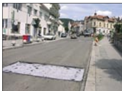
Oprava reflexních trhlin výrobkem Tensar Glasstex (Luhačovice)
