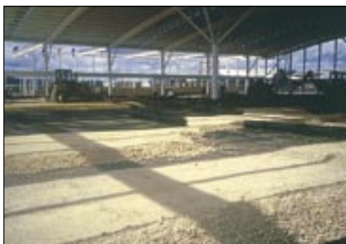
Roznášecí platforma pod betonovou podlahou rámové ocelové konstrukce
