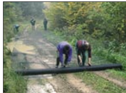
Pokládka dvouosé geomříže Tensar na lesní cestu (Soběšice)
