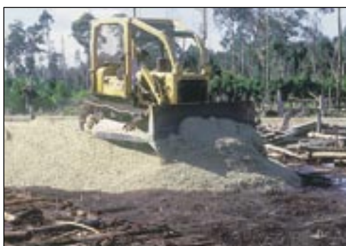
Výstavba komunikace s použitím roznášecí platformy přes rašeliniště
