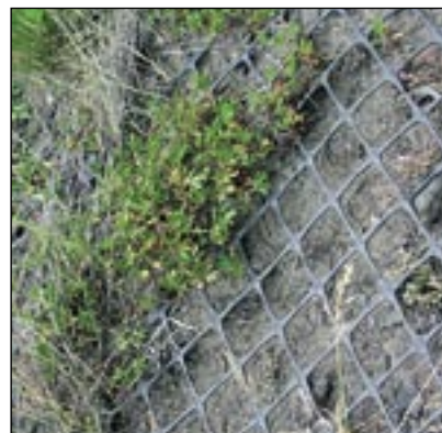
Geomříž GM4 je odolná vůči UV záření (Ostrov nad Ohří)
