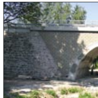
Výstavba mostních křídel z vyztužené země v Sebranicích
