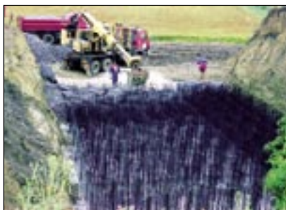
Zasypávání geobuňek zrnitým materiálem (Holubice)
