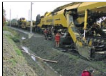
Pokládka geomříží jako součást technologie bez snášení kolejového lože (Jistebník - Polanka)
