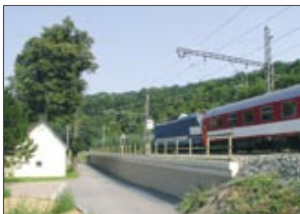
Vyztužená opěrná stěna na modernizovaném traťovém úseku Choceň – Ústí nad Orlicí
