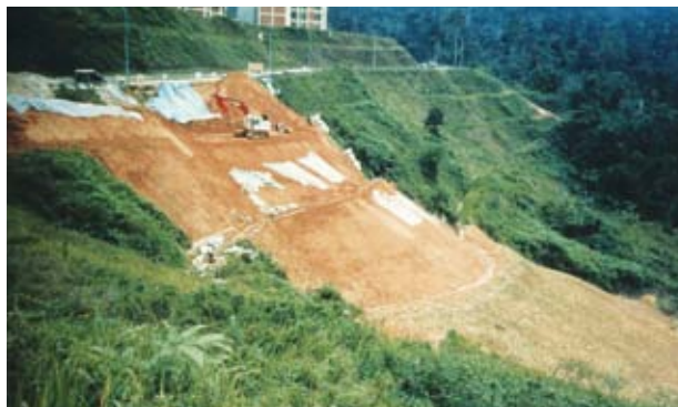
Systém TensarTech SlipRepair minimalizuje odvoz sesunuté zeminy a dovoz nového materiálu.
