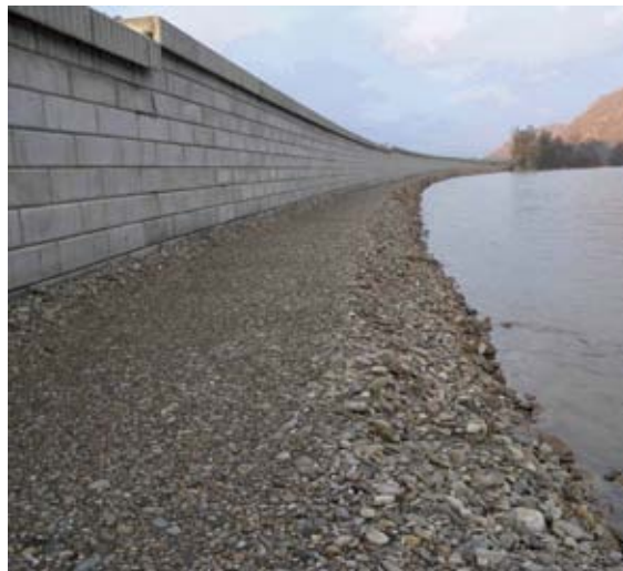
Opěrná zeď Tensar z pobřežních bloků se dobře hodí pro agresivní podmínky mořských pobřeží tak, jako v tomto přístavu.
