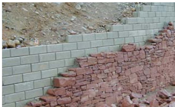
Opěrná zeď TensarTech TW s betonovými lícovými tvarovkami s pískovcovým obkladem spojeným nerezovými kotvami.
