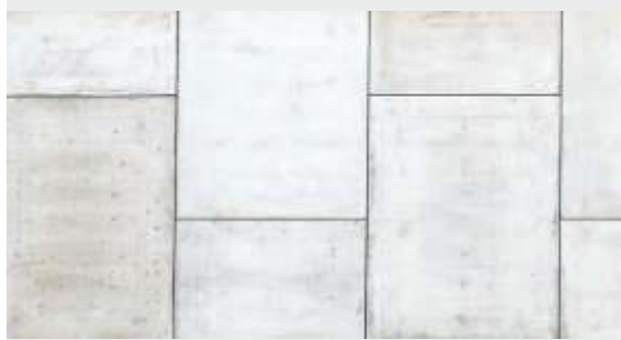
líc z velkoplošných betonových panelů
